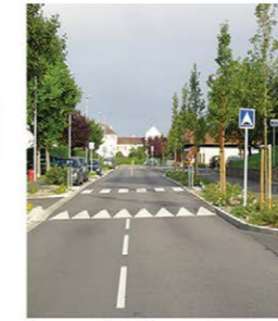
Square du Mâconnais
