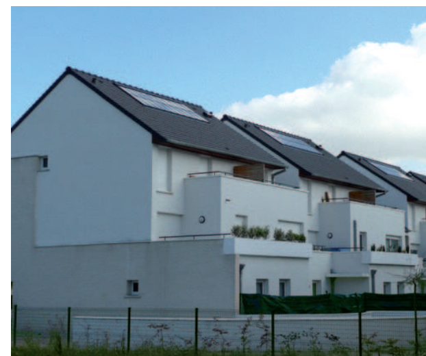
Régularité et simplicité pour l'implantation de ces capteurs thermiques qui suivent la logique de composition des volumes des toitures de cet ensemble de maisons.
