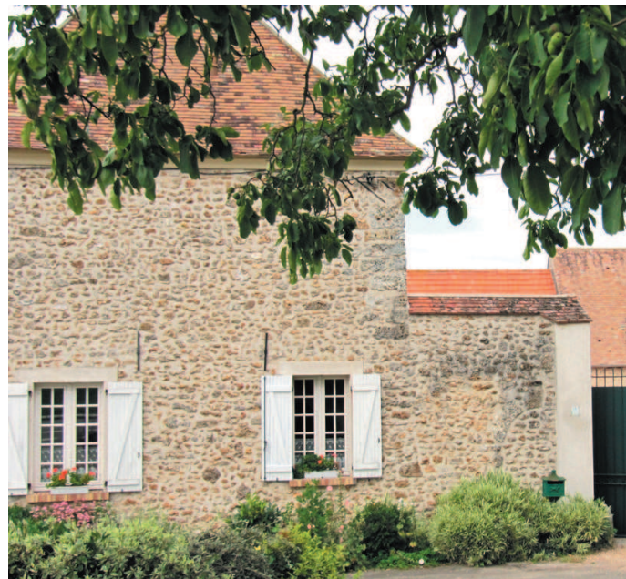
Les murs en pierre meulière de l'ancienne ferme Prud'homme à Maurepas (bâtiments du XVIII ème siècle)
