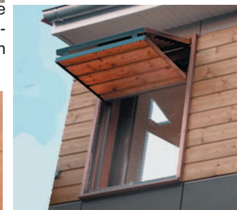
Le coffre du volet roulant est ici discrètement dissimulé derrière la vêtue
