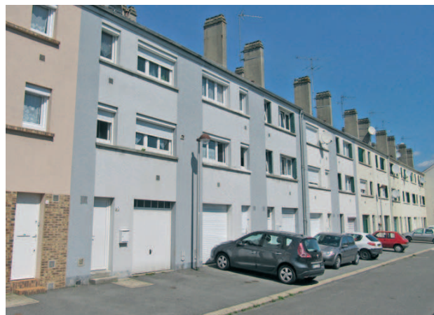
1/ Même si on peut leur reconnaître un aspect pratique, les garages des maisons Monceau, implantés en rez-de-chaussée en occupant l'essentiel du niveau, génèrent des façades urbaines austères et monotones.
