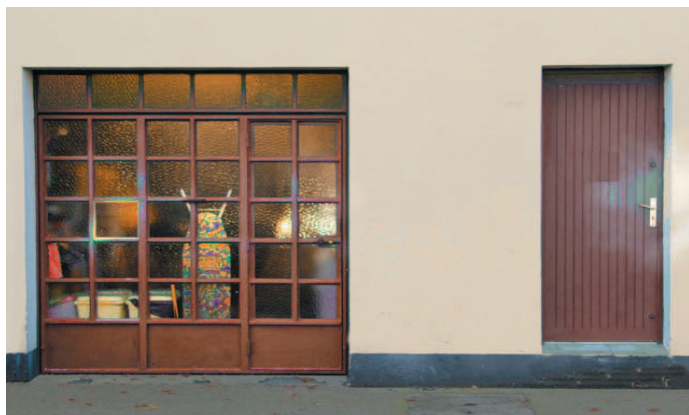
Un rez-de-chaussée de maison Monceau : une image révélatrice du détournement d'usage très fréquent des garages
