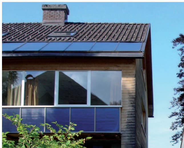
Les capteurs forment un bandeau horizontal qui prend appui sur la ligne d'égout du toit.
