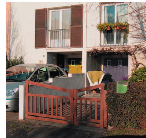
2/ Les accès aux garages des maisons Villeneuve, implantés également en rez de chaussée dans le volume habitable : ce sont des espaces peu qualifiés où vont se côtoyer stationnement des véhicules et séchage du linge.
