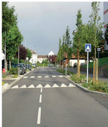
Square du Mâconnais
