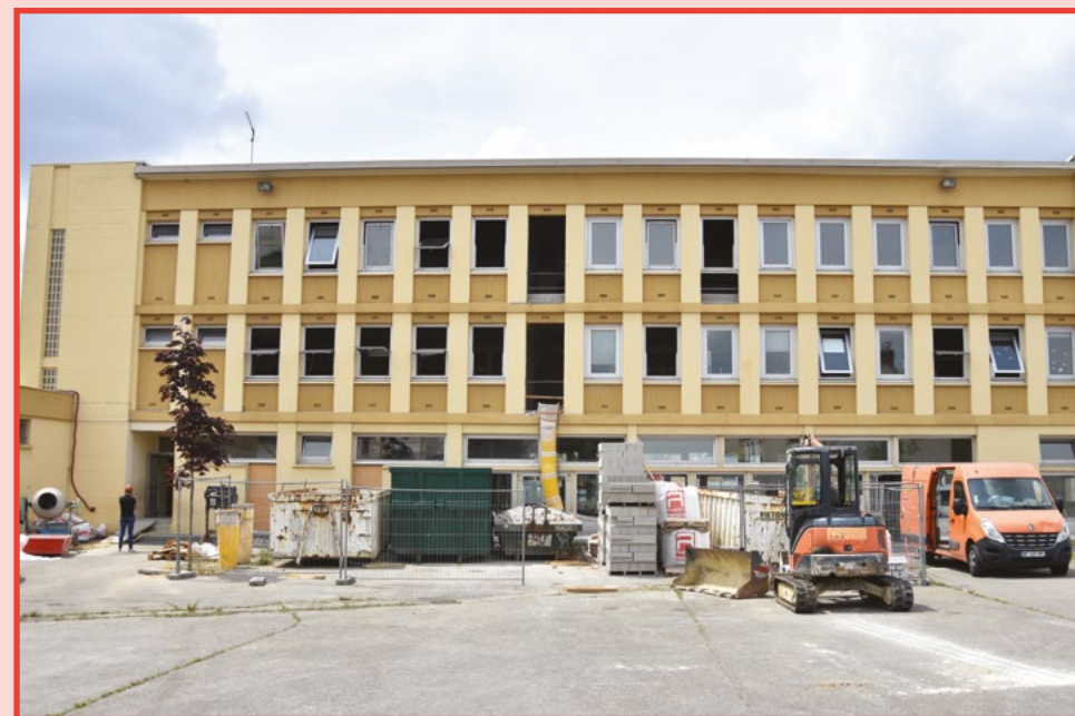
Les travaux d'extension et de réhabilitation du groupe scolaire de l'Agiot se poursuivent activement !
