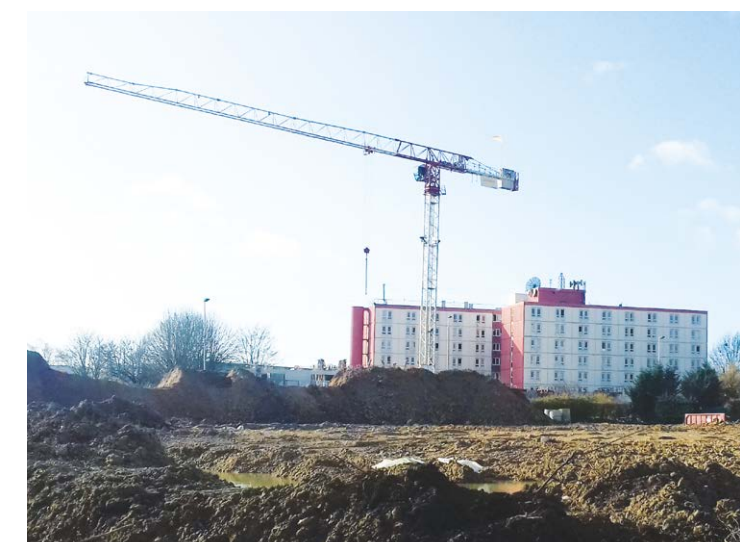
Construction de logements dans le quartier de la Malmedonne
