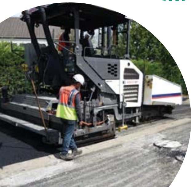
L'ENTRETIEN DE LA VOIRIE Opération estivale de renouvellement des enrobés.
