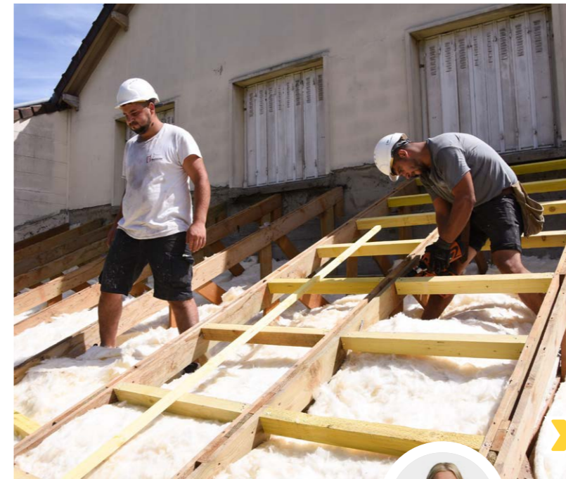
École de la Tour. Réfection et isolation thermique d'une partie de la toiture.
