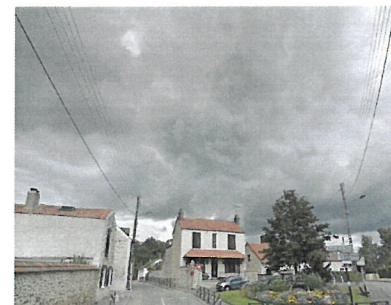
Réseaux aériens place des Buttes
