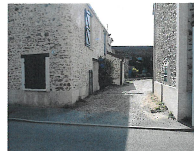
Les sols des entrées de fermes et des cours des maisons, gravillonnés, pavés se poursuivent jusqu'au caniveau pavé
