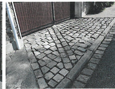
Les sols des entrées de fermes et des cours des maisons, gravillonnés, pavés se poursuivent jusqu'au caniveau pavé
